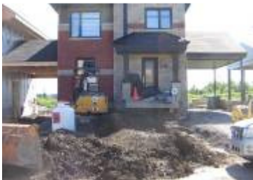
Les travaux ont débuté à la mi-juin chez Anne Paquette et vont bon train.
