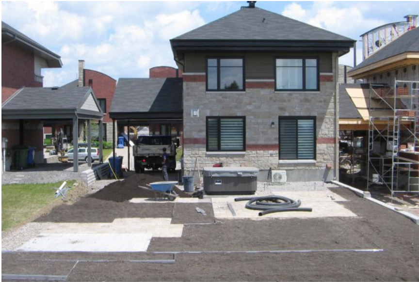
Les travaux ont débuté à la mi-juin chez Anne Paquette et vont bon train.
